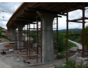
KörBild 12: Körnebachtalbrücke - Mai 2007
