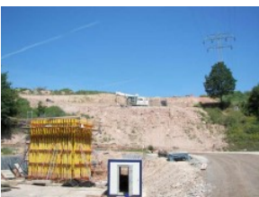
Bild 5: nördliches Widerlager der Körnebachtalbrücke - Juli 2006
