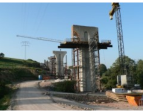
Bild 9: Körnebachtalbrücke - Bau der Pfeiler - Oktober 2006
