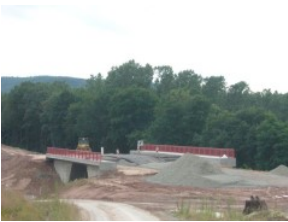
Bild 16: Anschlussbauwerk Süd - Juli 2007
