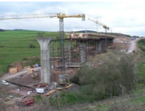
Bild 10: Körnetalbrücke - Einschalung des Überbaus - November 2006
