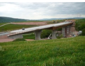
Bild 11: Körnetalbrücke - Blick in südliche Richtung - Mai 2007
