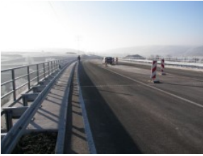
Bild 20: Körnebachtalbrücke; Blick in Südliche Richtung - Dezember 2007
