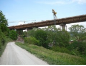
Bild 13: Körnebachtalbrücke - vor dem Ausschalen - Mai 2007
