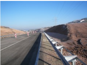
Bild 17: Ende der Körnebachtalbrücke; Blick in nördliche Richtung - Dezember 2007
