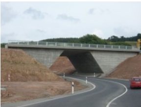
Bild 15: Anschlussbauwerk Nord - Juli 2007
