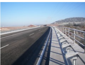
Bild 18: Körnebachtalbrücke in Richtung Norden - Dezember 2007
