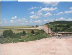
Bild 4: Standort (analog Bild 2) südlich des Körnebachtals - während des Baues (nördliche Richtung - nördliches Widerlager) - Juli 2006
