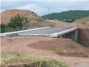
Bild 14: Talbrücke Klinge - Juli 2007
