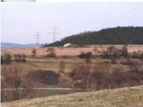
Bild 2: Standort südlich des Körnebachtals vor Baubeginn - Blick in nördliche Richtung (geplante Trasse links der 110kV - Freileitung) - Herbst 2005
